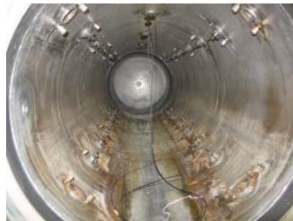
Interiören i en impregneringscylinder.
