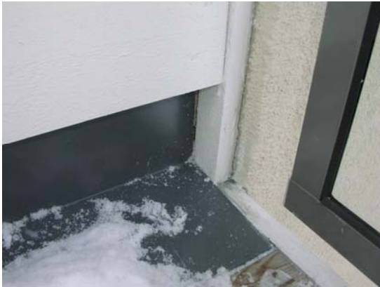
Bild 7. Otätheter vid balkong
