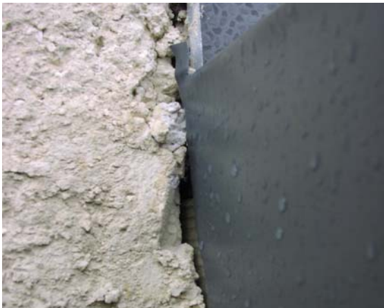
Bild 9. Otäthet i anslutning till skärmtak
