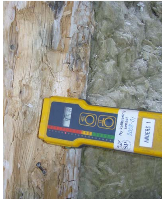
Regeln är genomsur och kraftigt rötangripen
