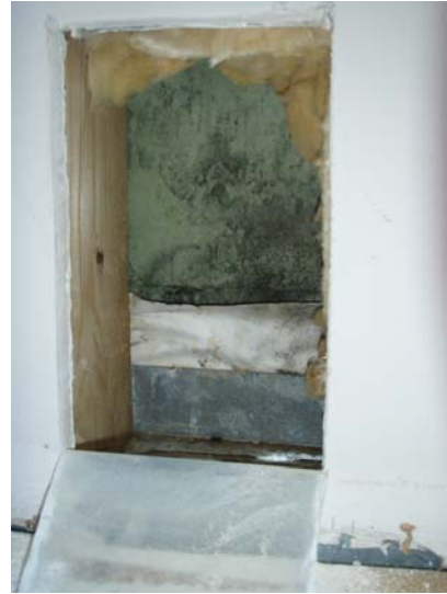
Bild 2. Mikrobiell påväxt på den yttre gipsskivan orsakad av att vatten trängt in vid en otät anslutning
